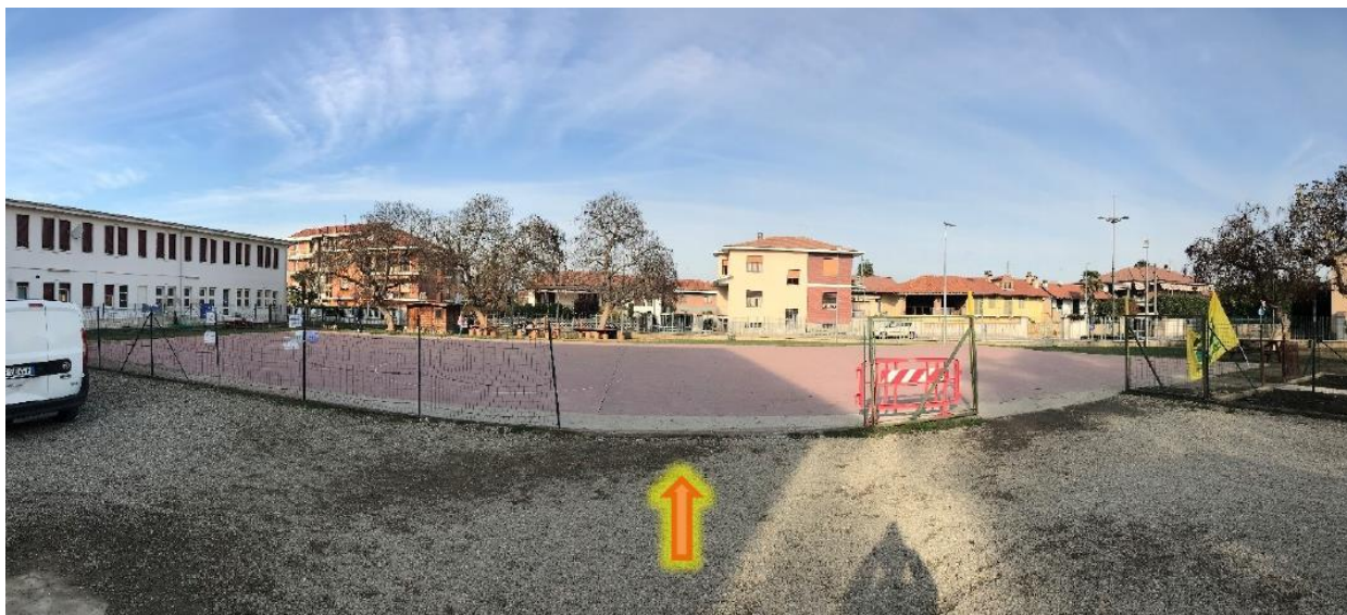
Vista dell'accesso dalla Scuola Primaria
