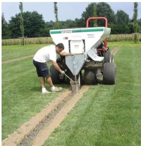
*Figura 12 Sistema di drenaggio superficiale*
