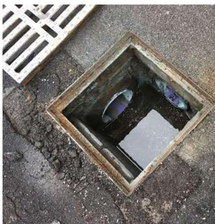
*Figura 2 Pozzetto di ispezione*
