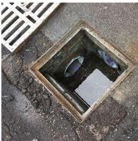
*Figura 11 Pozzetto di ispezione*
