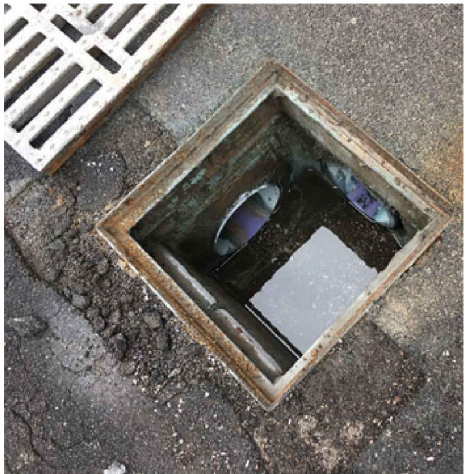
POZZETTO DI ISPEZIONE
