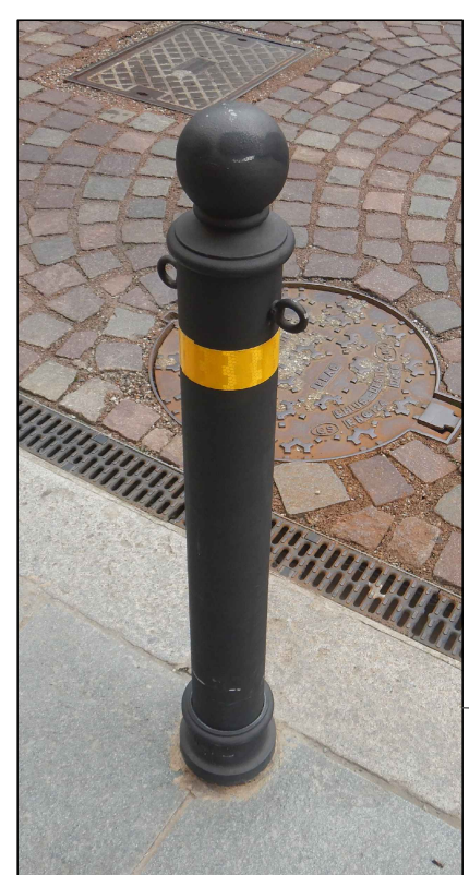
Dissuasore in ghisa Ø10 cm h. 100 cm, color grigio antracite fiammoproteggiato e fascia catatirangente
