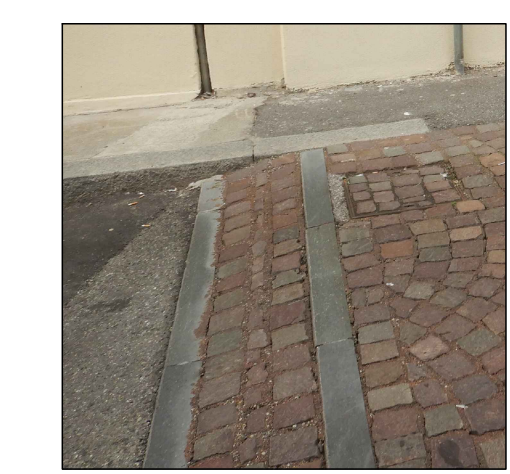
Dettaglio - raccordo tra pavimentazione in porfido e asfalto
