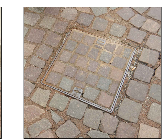
Dettaglio - pozzetto con telaio porfidato
