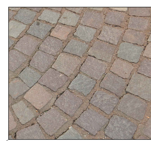
Posa porfido a coda di pavone; Sigillatura fughe mediante trattamento con resina poliuretanica TIPO "FLEXYSTONE" o similare
