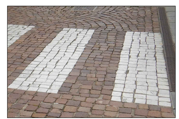
Dettaglio - ATTRAVERSAMENTI PEDONALI Le strisce zebraite andranno realizzate alternando file di cubetti in porfido con altre di marmo bianco di Carrara passo 50 cm larghezza 2,5 m
