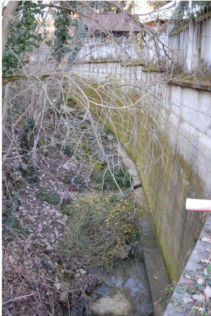
**Figura 16:** *Il canale sul fondo dell'avvallamento a sud-est del progetto; la parete nord è rivestita di cemento per proteggere gli edifici recenti costruiti a bassa quota.*
